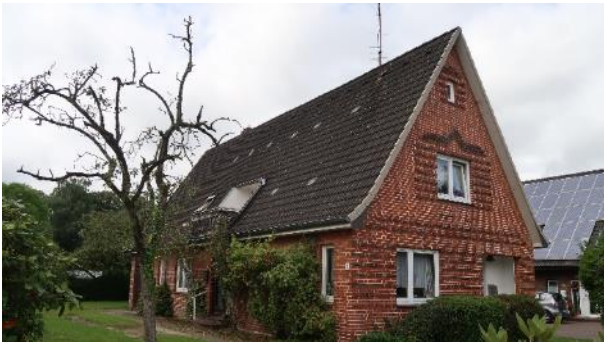
Abbildung 15: Einzelhaus Pöschendorfer Straße
